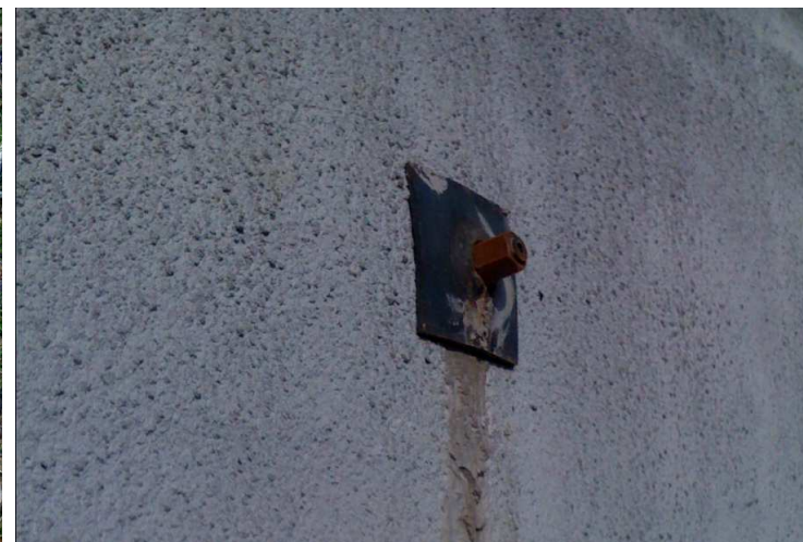
Piastra per parete chiodata con spritz beton
