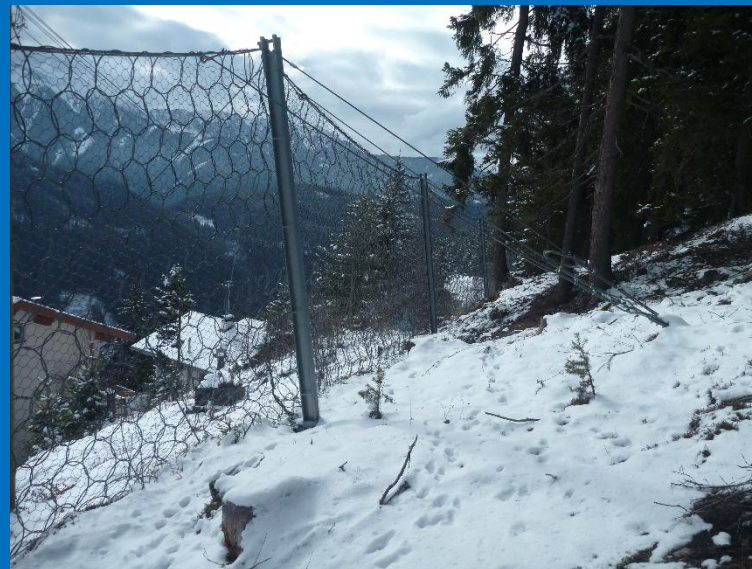
Bestehender Steinschlagschutzzaun Barriera paramassi esistente
